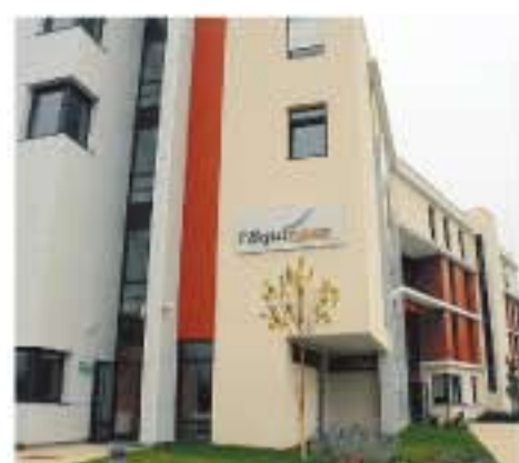
Inauguré en octobre, le Centre d'Hébergement et de Réinsertion Sociale L'Équinoxe a ouvert ses portes derrière le collège Les Prés à l'initiative du Conseil Général.
