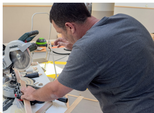
Sur les chantiers estivaux (ici à la crèche La Comtesse de Ségur), les corps de métier se sont succédé.
