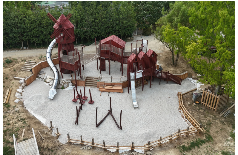
La transformation du parc Alain Chedeville est bien avancée à la Sourderie.
