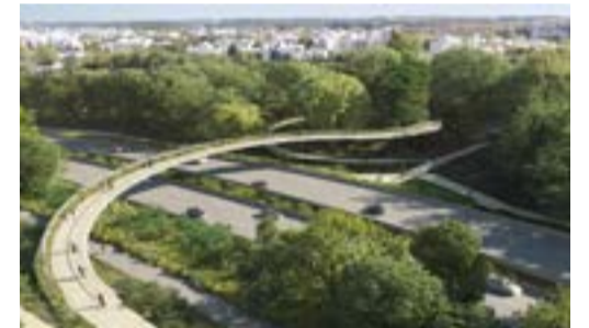
La prochaine passerelle bientôt en travaux permettra de relier la ville à l'Île de loisirs depuis l'avenue des Prés.
