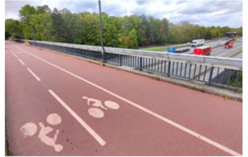
Réservée aux deux-roues et aux piétons, la passerelle Laurent Fignon relie le secteur résidentiel du Pas du Lac à la place de la Paix Céleste.
